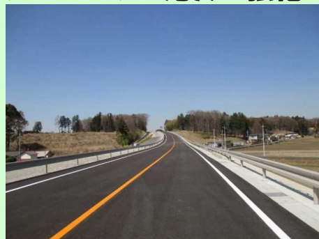
国道408号 宇都宮高根沢バイパス
