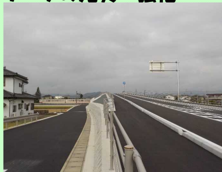
県道大橋家中線 家中工区
